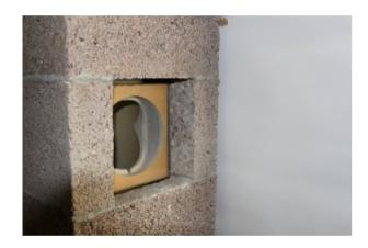
Das Problem, vor dem viele Neubesitzer eines Ofens stehen: Die Öffnung im Schornstein, der sogenannte **Rauchrohranschluss**, ist größer oder kleiner als der Durchmesser des Rauchrohrs (oder aber - im Fall eines **nachträglichen Einbaus** - gar nicht vorhanden).
