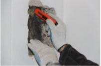
Halten Sie das Anschluss-Set an die gewünschte Stelle des Mantelsteins und zeichnen Sie den Umriss des Adapterstücks nach. Schneiden Sie die Wandöffnung mit einem Winkelschleifer (Steinscheibe) aus und entfernen Sie die Mineralwolldämmung mit einem Cutter.
