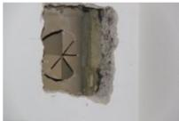
Halten Sie den Adapter an das Innenrohr des Schornsteins und zeichnen Sie den Lochkreis an. Schneiden Sie die Rohröffnung mit einem Winkelschleifer zunächst sternförmig ein und schneiden Sie auch die Kontur des Lochs an um eine Sollbruchstelle zu erzeugen. Dies verhindert das unkontrollierte Ausbrechen am Rand der Öffnung. Entfernen Sie nun die ausgeschnittenen Segmente.
