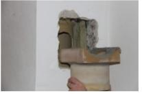
Entfernen Sie Staubreste auf dem Innenrohr und feuchten Sie die Klebestelle mit einem Schwamm leicht an. Setzen Sie das Adapterstück mit dem mitgelieferten Säurekitt an.
