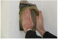
Setzen Sie das Adapterstück auf die Öffnung und glätten Sie die Kittfuge mit einem Schwamm. Fixieren Sie den Adapter mit Holzkeilen oder einer Schraubzwinge. Nach 24 Stunden ist der Säurekitt ausgehärtet. Setzen Sie nun die Rohrschalen-Dämmung auf das Rohr und stopfen Sie die Wandöffnung mit der in Schritt 1 ausgeschnittenen Mineralwolldämmung aus.
