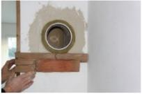
Verputzen Sie die Wandöffnung und setzen Sie abschließend das metallische Doppelwandfutter ein. Optional kann der Mantelstein z.B. mit Verblendern von BisoArt verkleidet werden.
