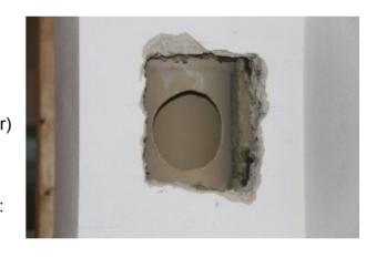
Es ist keine Öffnung im Schornsteinrohr, ein sogenannter **Rauchrohranschluss**, vorhanden. In diesem Fall muss der Anschluss nachträglich am Innenrohr des Schornsteins angebracht werden.
